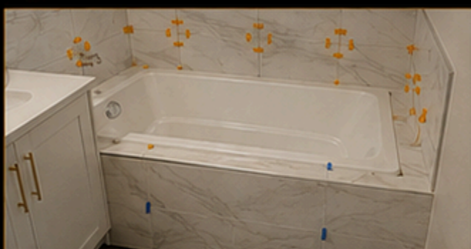
10 MARMOR BADEWANNE ROHBAU
