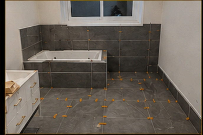
03 GRAUES BADEZIMMER ROHBAU
